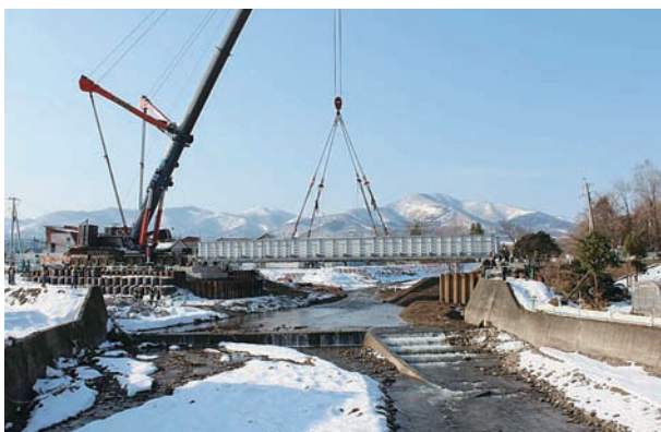
復旧したJR鉄橋
