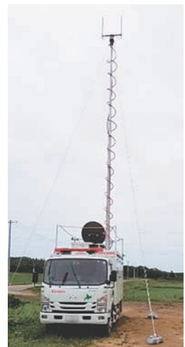
写真1 厚真町に設置した基地局車
