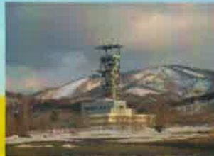
三井砂川炭鉱中央立坑橋 (上砂川町)
