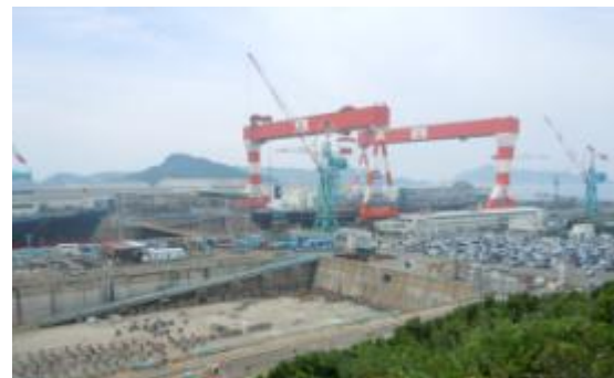
600トン門型クレーン クレーン中央の三菱マークの白地部分は テニスコートとほぼ同じ大きさ
