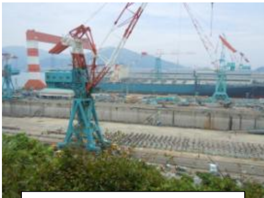
左奥が1,200トン門型クレーン
