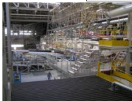
No.2 Dock 奥から
