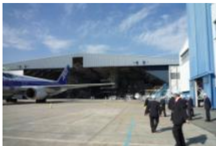
第二格納庫 左側～中央部が No.4 Dock 右側が No.5 Dock 小さく見えるのが DHC8-Q400
