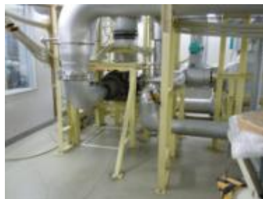
B777 エアコンの試験装置
