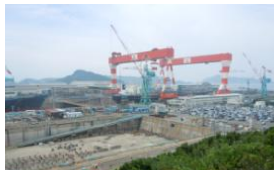
600トン門型クレーン クレーン中央の三菱マークの白地部分は テニスコートとほぼ同じ大きさ
