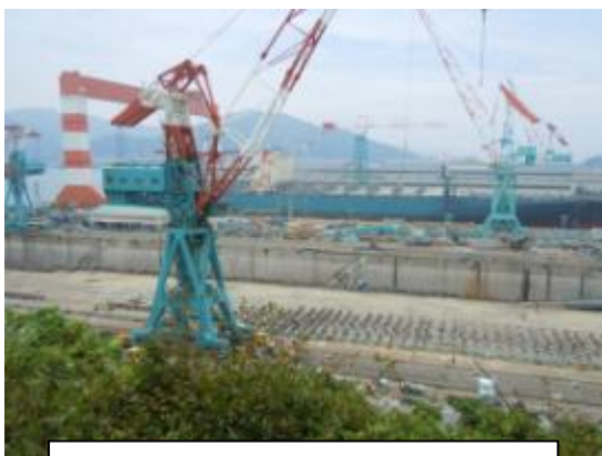
左奥が1,200トン門型クレーン
