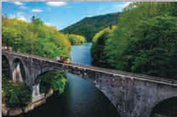
【春】第三音更川橋梁
