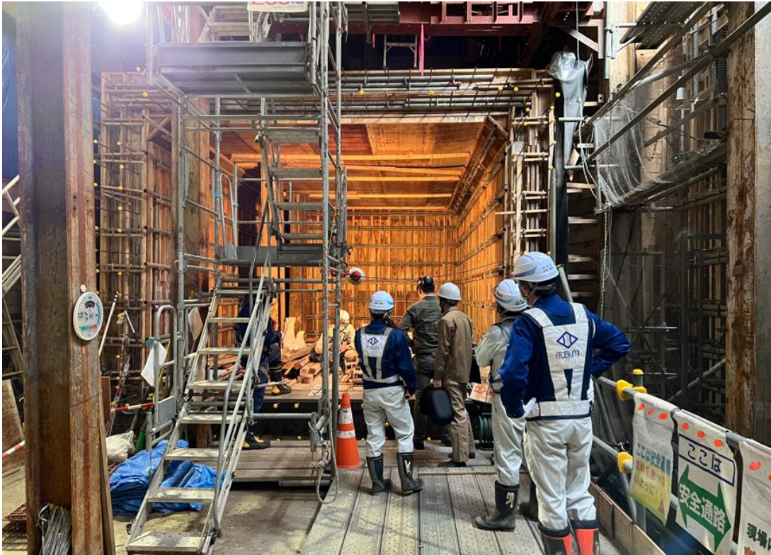
▶ 底版コンクリートを打ち終わり躯体工事に着手
