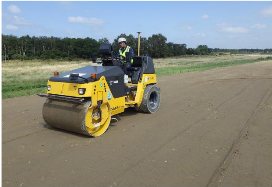
盛土転圧状況
