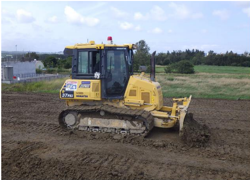
盛土敷均し状況
