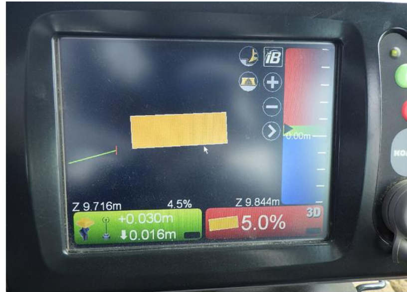
車載モニターで排土板高さ確認(セミオート)
