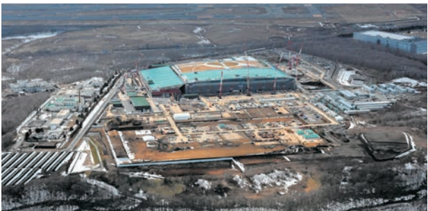
2023年9月 Rapidus(株)工場「IIM-1」の建設着工
